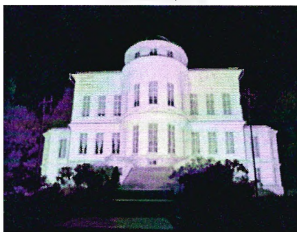
Здание, расположенное в зоне охраны объектов культурного наследия
