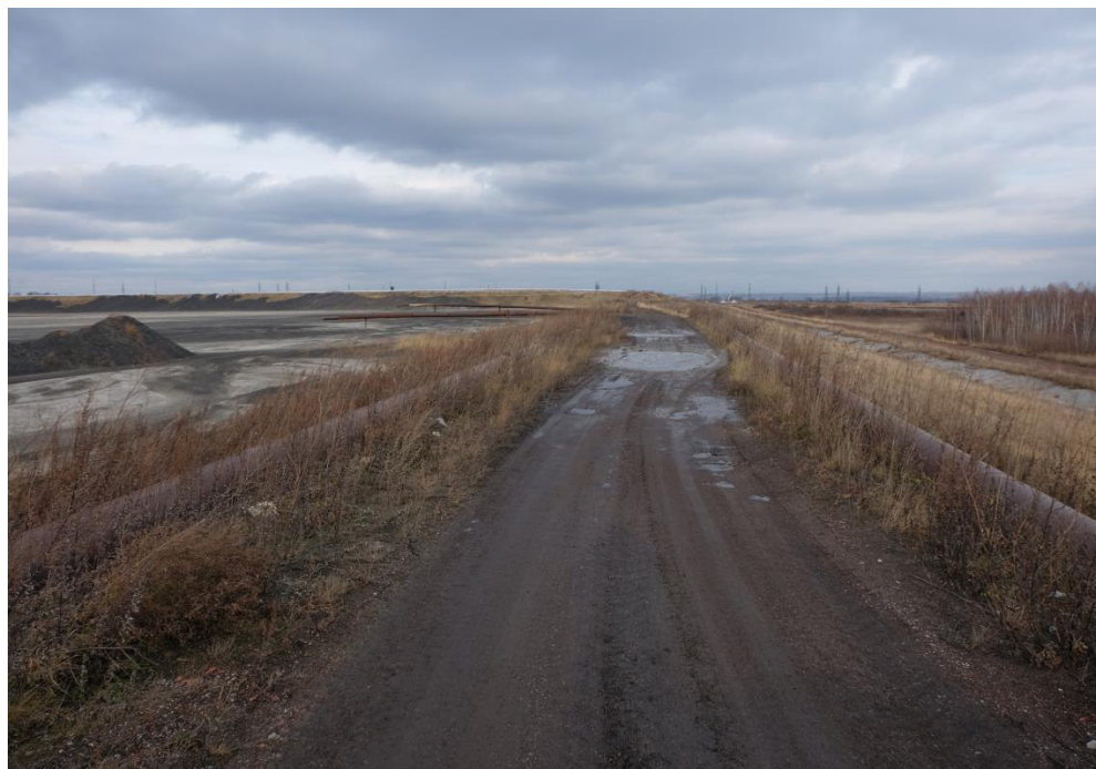
Рисунок 5. Грунтовая дорога по верхней части насыпи и характер растительности по обочинам дороги на участке золоотвала ТГ 5.
