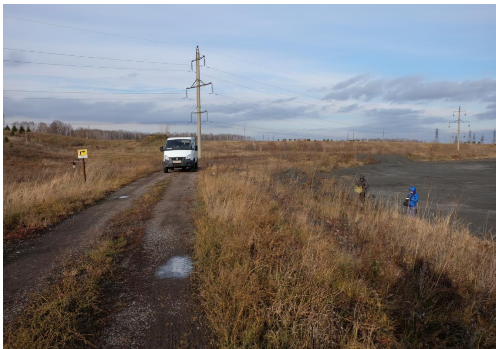
Рисунок 9. Рудеральная растительность на внутреннем откосе и вокруг технологической дороги на угловой точке (Т1) золоотвала № 2.
