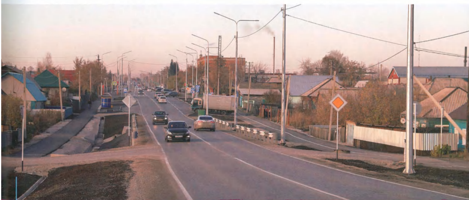
• Новая дорога на ул. Пролетарской
