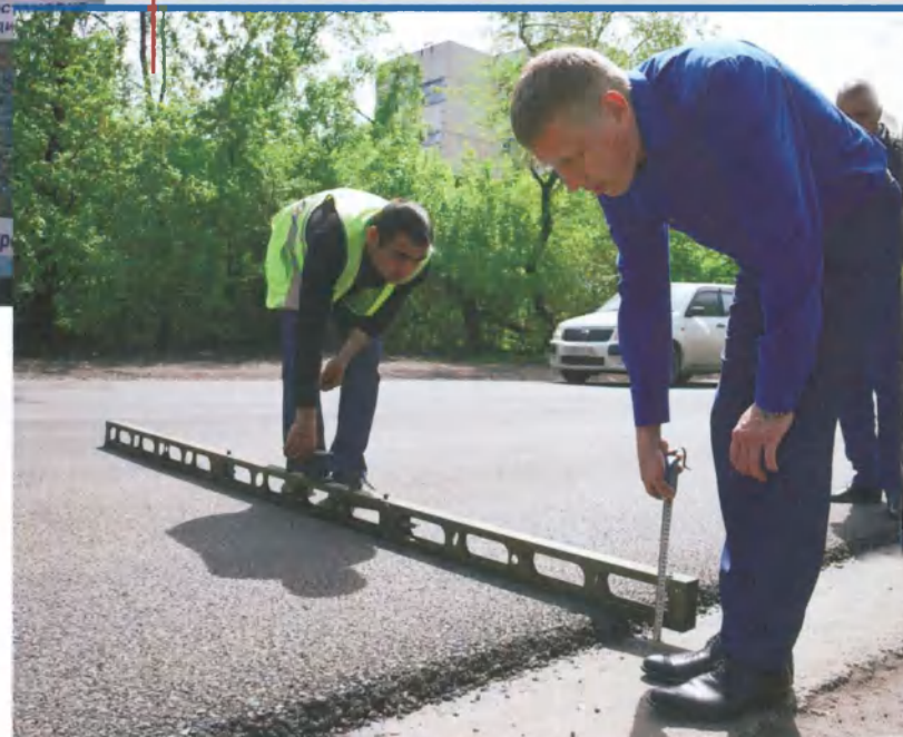
Летом 2018 года отремонтирована автодорога, соединяющая центр города с поселком Новый Городок
