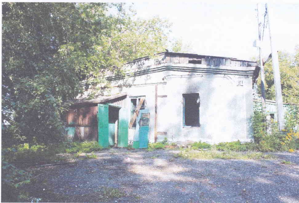
Фото 1. Главный фасад здания в осях Г - А
