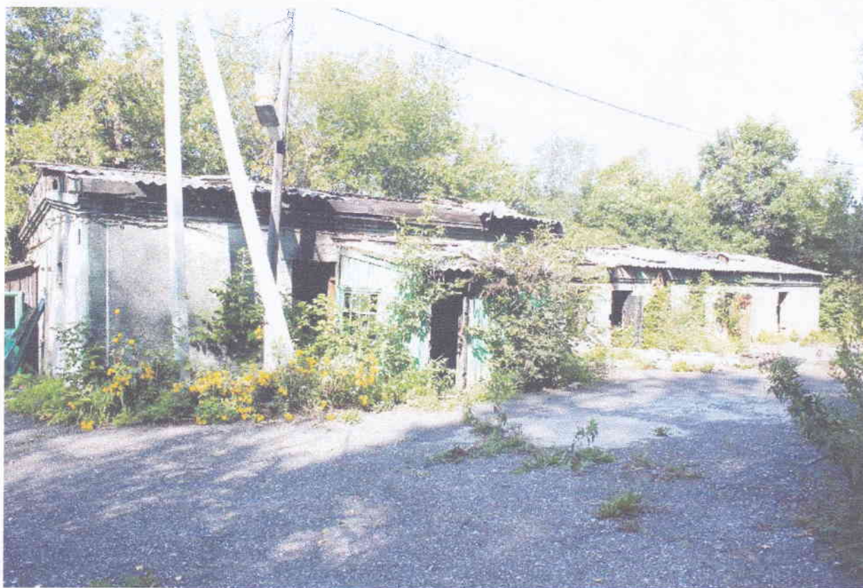
Фото 2. Фасад в осях 1 - 5
