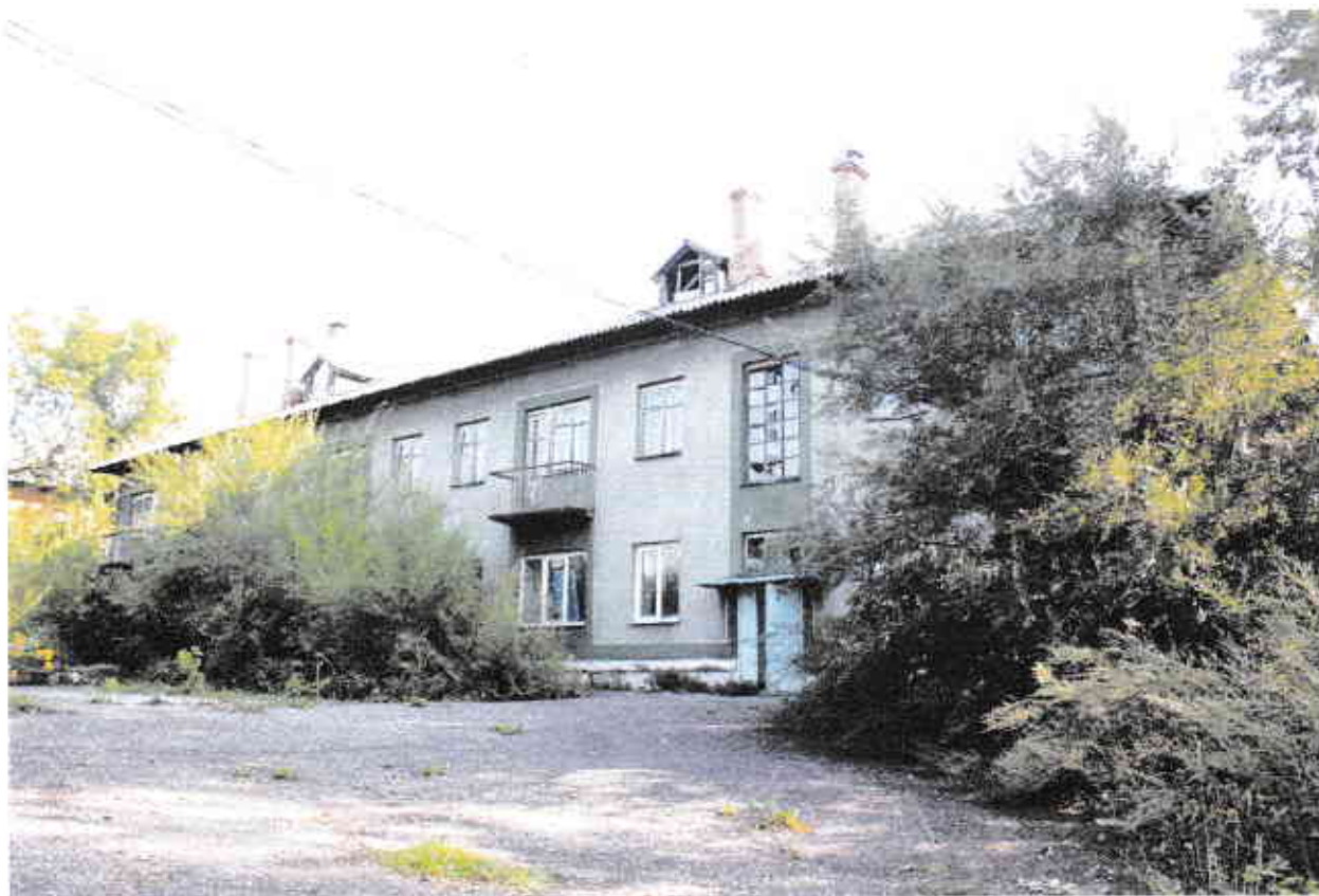
Фото 1. Главный фасад здания в осях 1-6
