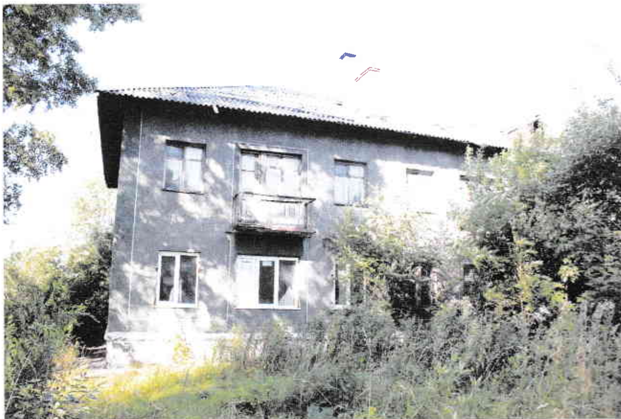
Фото 2. Фрагмент заднего фасада здания со стороны оси 6
