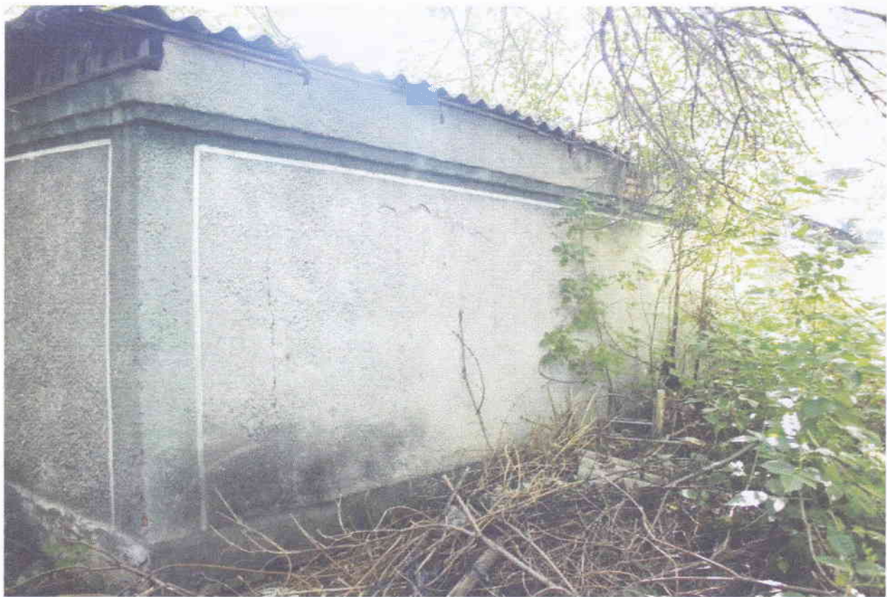
Фото 4. Фасад в осях 5 - 2
